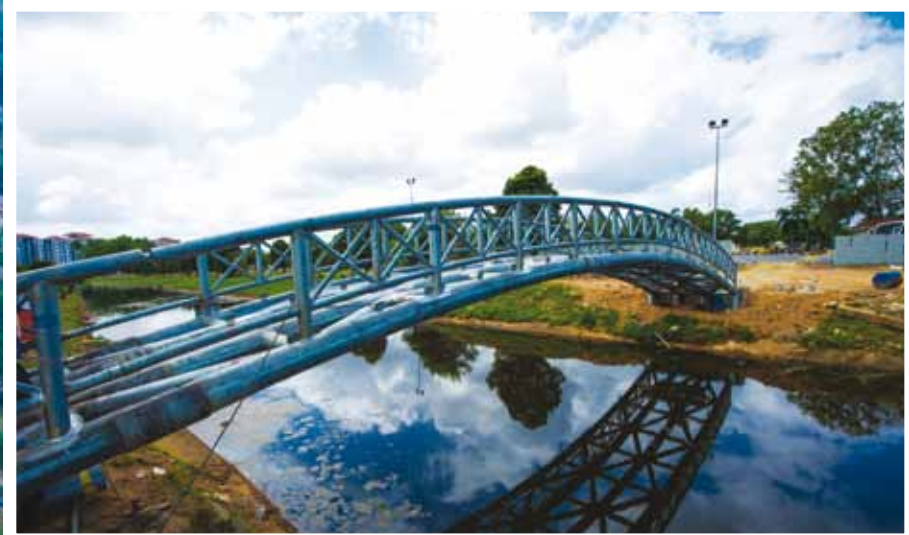
Salah satu projek tambatan banjir yang telah dilaksanakan di kampus UMT.
