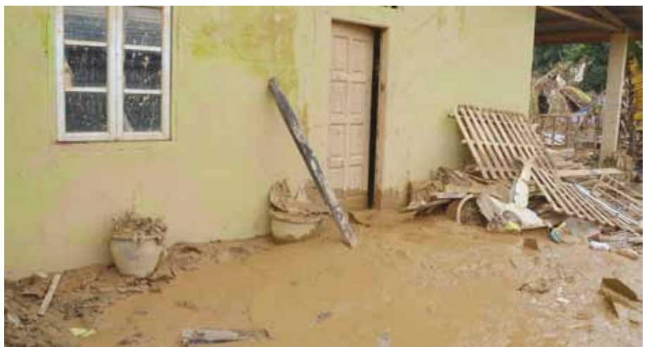
Selut yang mendatangkan bau yang kurang enak masih menebal di salah sebuah rumah mangsa banjir.
